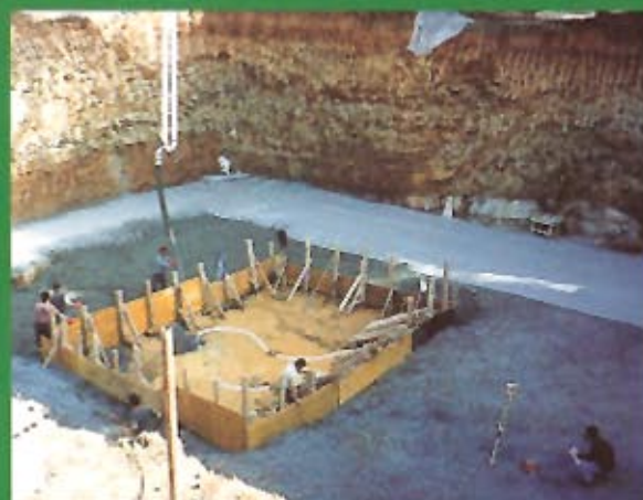
Visoka gradnja (Turčija)
