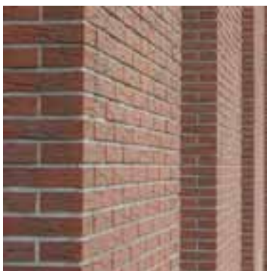
Mauerwerksoptik mit Riemchen; von echtem Mauerwerk nicht zu unterscheiden
