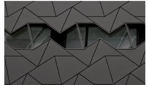
Fassadendetail Winterfestspielhaus Erl A: delugan meissl associated architects, Wien
